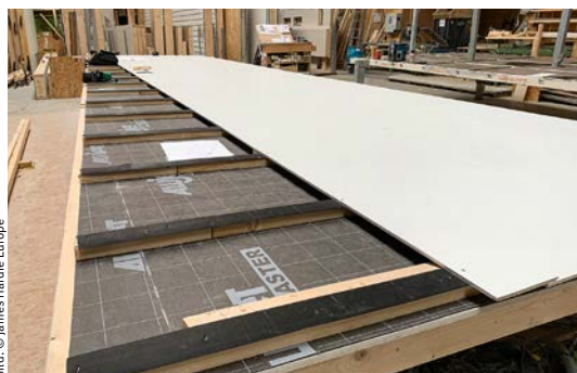
Vormontage am Montagetisch im Werk in Windach-Hechenwang
