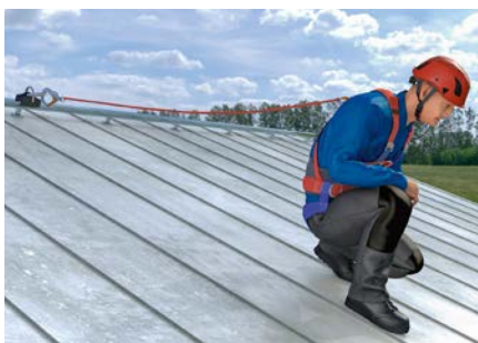
Beispiel für ein Rückhaltesystem mit fester Länge, befestigt an einer dauerhaft am Objekt befestigten Anschlagvorrichtung mit einem beweglichen Anschlagpunkt
