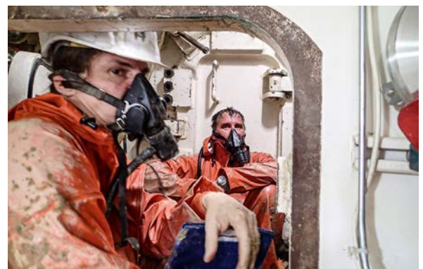
Spezieller Atemschutz bei Drucklufteinstieg: Atemschutzmaske mit externer Luftversorgung über Schläuche
