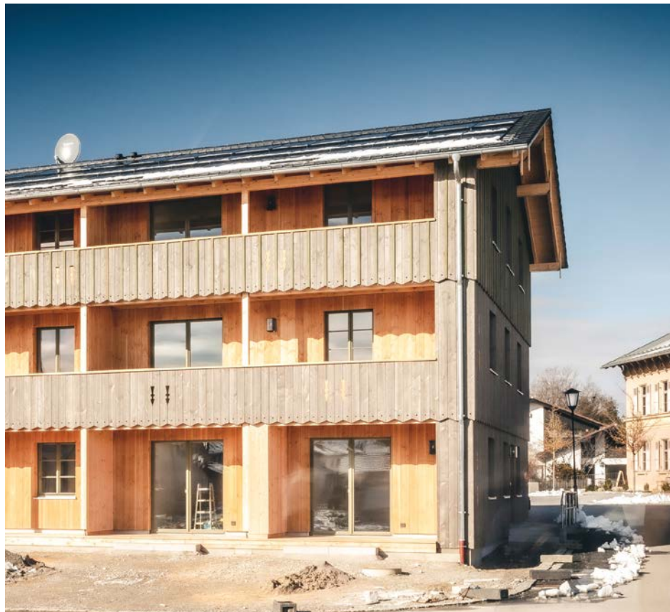
Allein durch die große Menge der eingesetzten Holzbauelemente und Zellulosedämmstoffe wirkt das Gebäude in Iffeldorf als CO 2 -Senke und speichert Kohlenstoff von rund 160 t CO 2 .
