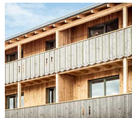
Das Mehrfamilienhaus mit Holzverkleidung im alpenländischen Stil bringt die Holzbauweise zur Geltung.
