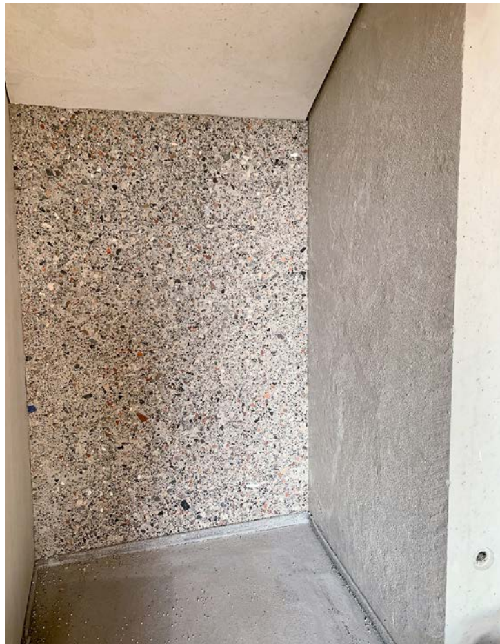
Eine sichtbare RC-Wand im Mehrfamilienhaus
