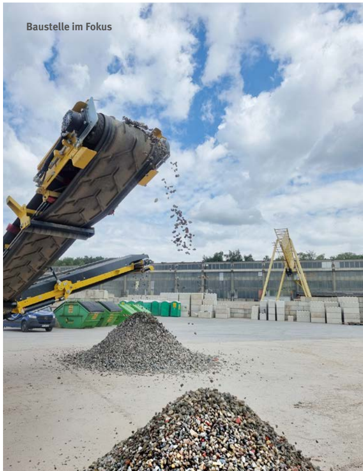
Aufbereitung des Abbruchmaterials
