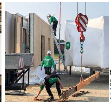
Transport und Montage der Module
