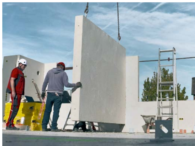
Montage der Erdgeschosswände
